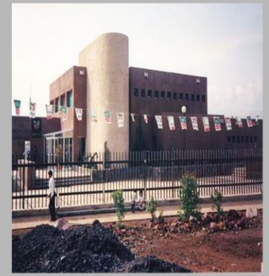
IMSS Hospital Estado de Mexico, Chalco
