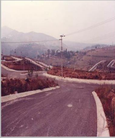
"Atizapan section II" Estado de Mexico
