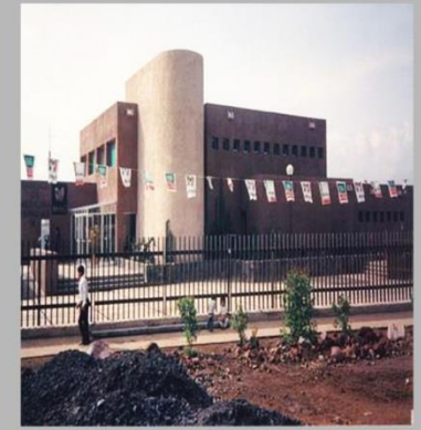
IMSS Hospital Estado de Mexico, Chalco
