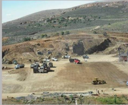
Plataformas y Terracerías
