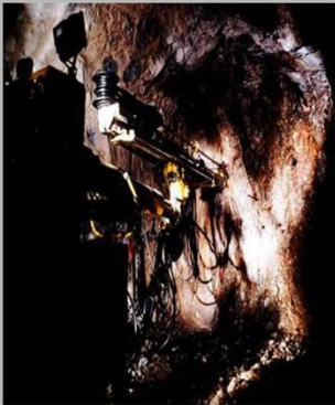
Perforación Rampa "San Alvar" Zacatecas
