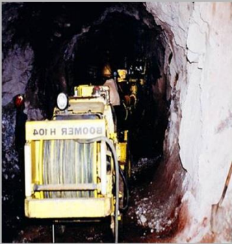
Perforación de Túneles
