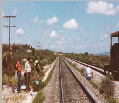
Obras Complementarias via férrea "Mexico-Queretaro"
