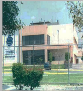
Edificio Syntex Cuernavaca
